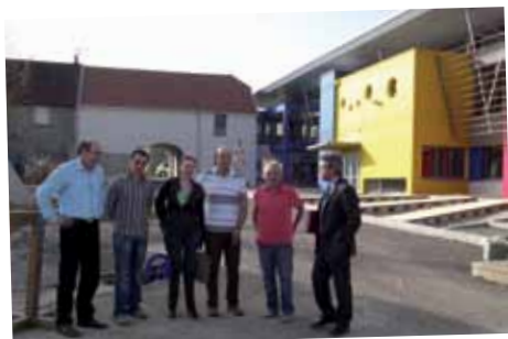
Visite de chantier à Noidans-le-Ferroux avec les élus.
