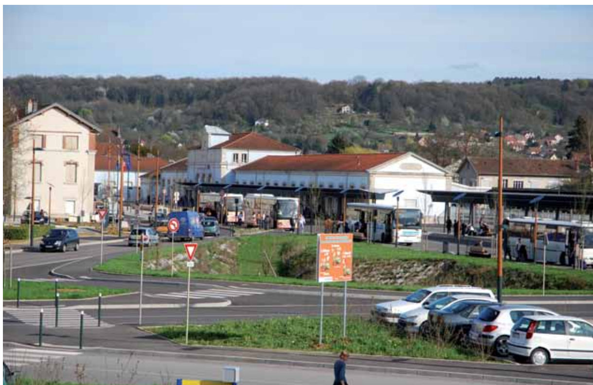
La nouvelle gare multimodale aménagée par la Communauté de Communes de l'Agglomération de Vesoul.
